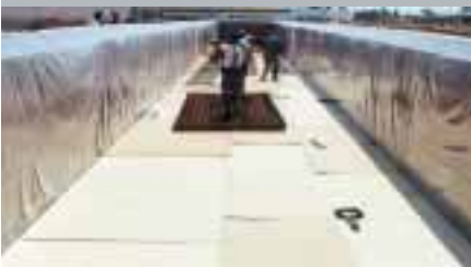
Figura 3: Preparación del colado de la cimentación
